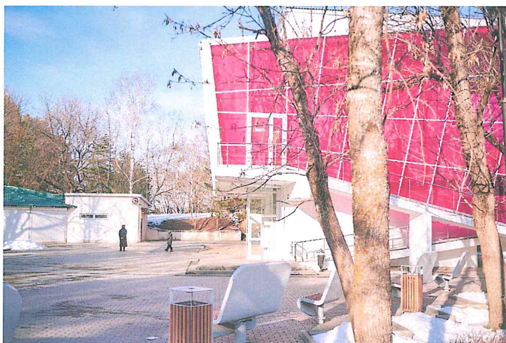
Фото 12. Нижняя станция канатной дороги
