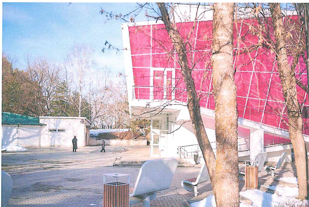
Фото 5. Нижняя станция канатной дороги
